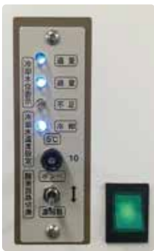
チラーシステム メンテナンスパネル
